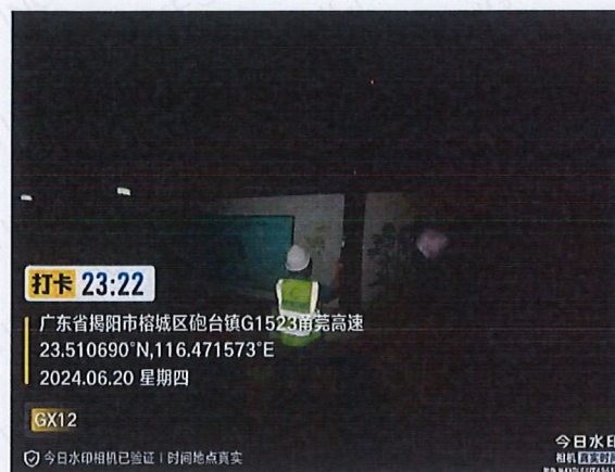
施工 2 标 GX12（北）侧外米 2#
