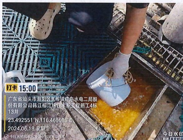
施工 4 标 GX13 厨房生活污水
