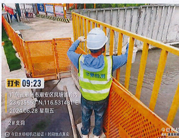
施工 1 标 2#支洞隧道洞口排水
