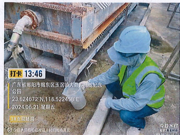
施工 1 标 3#支洞隧道洞口排水
