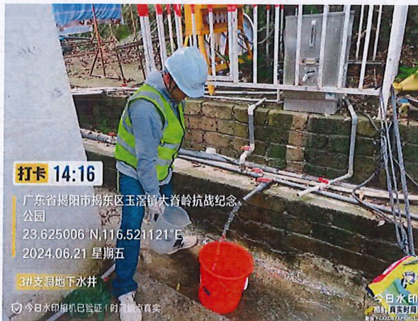
施工 1 标 3#支洞地下水井
