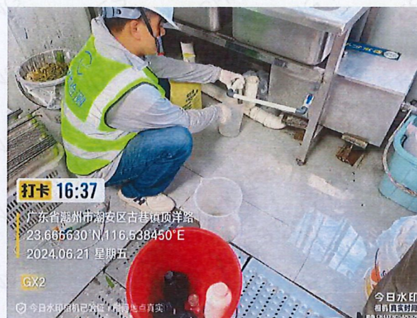
施工 1 标 GX2 厨房生活污水
