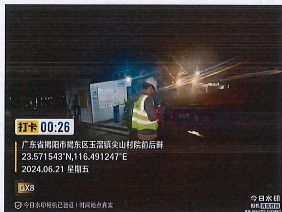
施工2标GX8（南）侧外米2#
