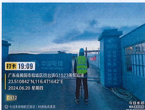
施工 2 标 GX12（西）侧外米 1#
