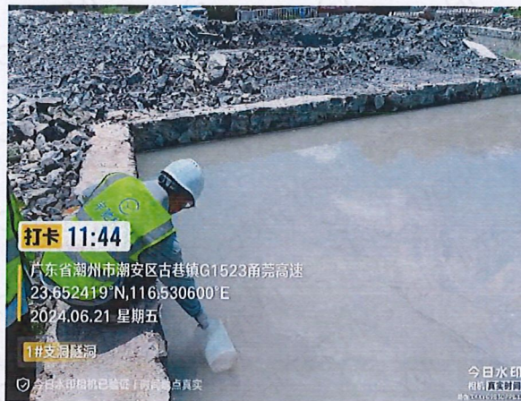
施工 1 标 1#支洞隧道洞口排水
