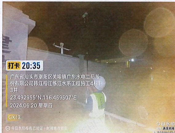
施工4标GX13（北）侧外1米1#
