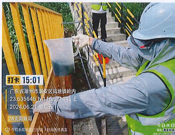
施工 1 标 2#支洞隧道洞口排水
