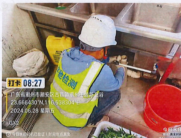
施工 1 标 GX2 厨房生活污水
