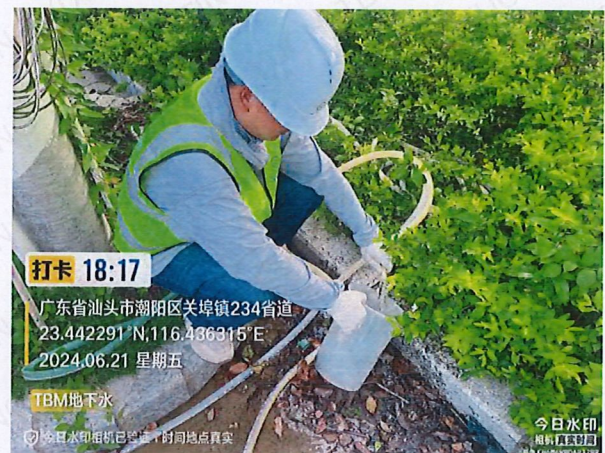
施工 5 标 TBM 进口 (旁田东村距离八百米地下水井)
