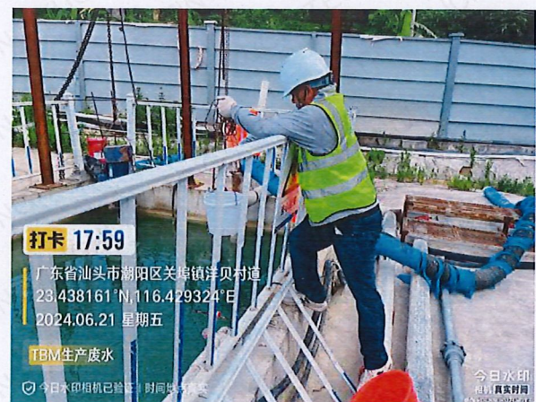
施工 5 标 TBM 隧道开端洞口排水
